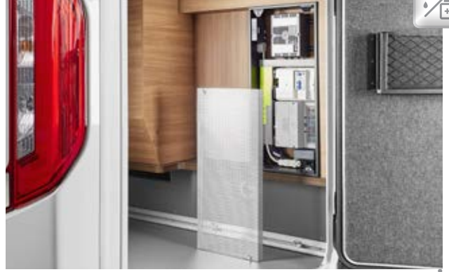
Elektrosentral lett tilgjengelig i scootergarasjen
