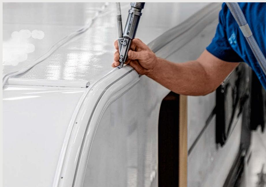
**Stabil Pro.Tec Frame.** Pro.Tec-rammen er en spesielt solid aluminiumsramme som forbinder alle veggene og tak med hverandre. Den forbedrer påbyggets stabilitet og dermed også levetiden til hele kjøretøyet. Et spesielt høydepunkt: I Pro.Tec-rammen er det plassert et kammer for tettemassen. Slik holder den seg på plass og ødelegger ikke helhetsinntrykket (bobiler/modellavhengig).
